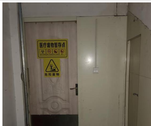
医疗废物暂存间
