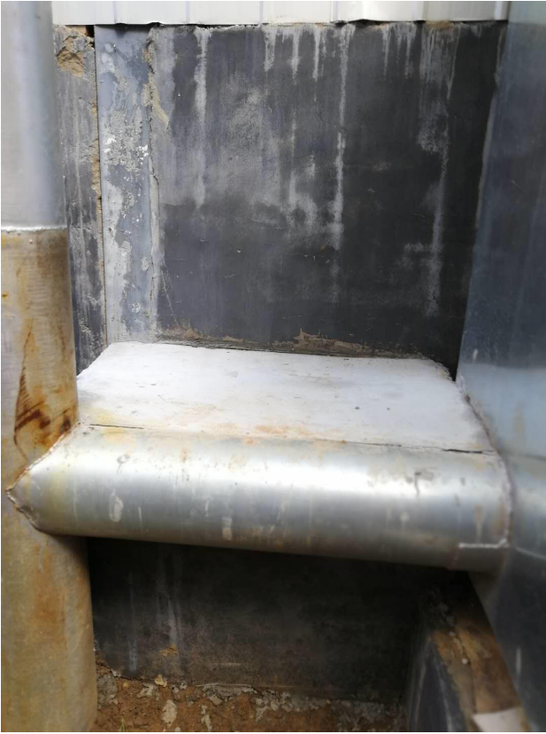
检测口处平台建好
